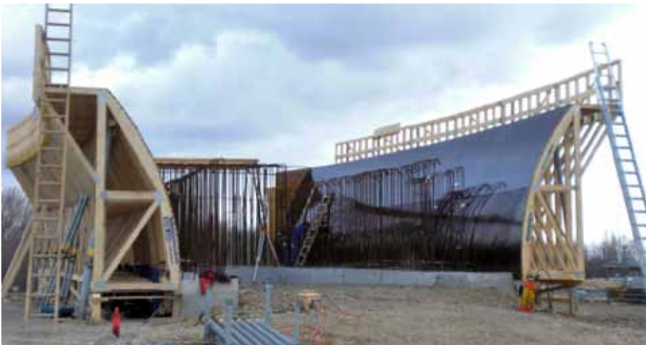
S33.Ü13 Widerlagerschalung mit „Tulpenschalung“
