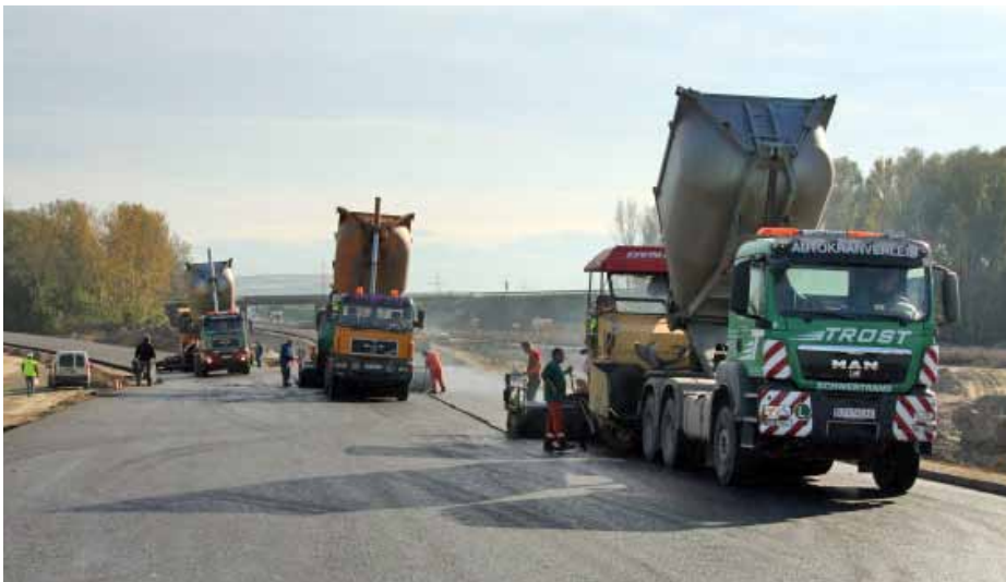
Asphaltierung Knoten Traismauer - Rampe 3
