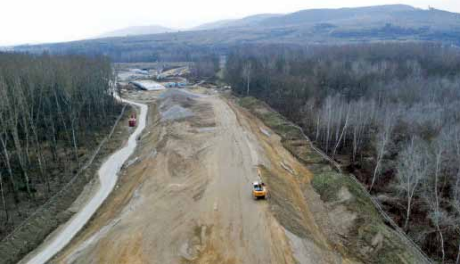
Dammschüttung der Haupttrasse S33
