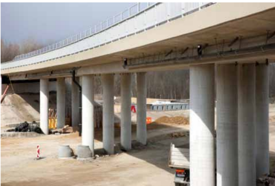
S33.Ü14 - Unterbau, Randbalken, Geländer
