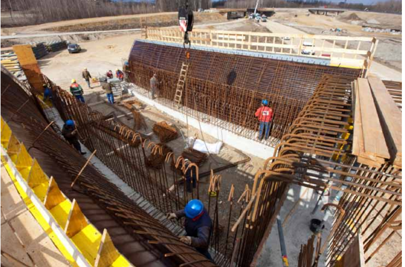
S33.Ü13 - Bewehrungsarbeiten am tulpenförmigen Widerlager
