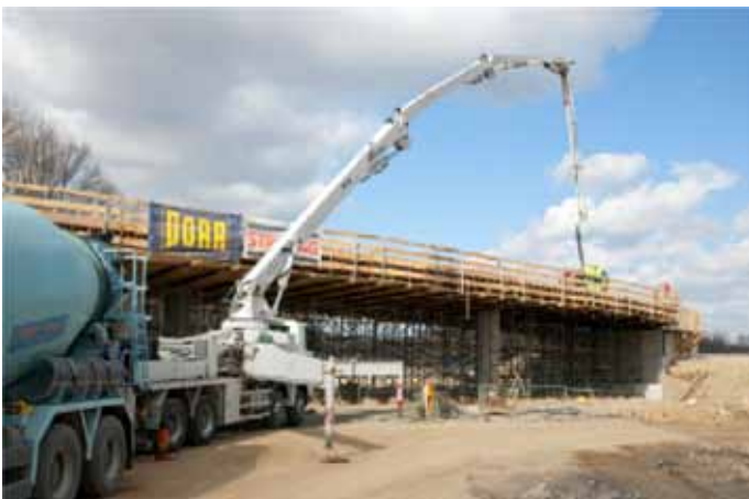
Tragwerksbetonage B37.Ü01 (ca. 510m 3 )
