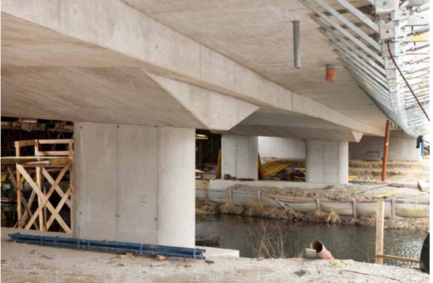
Brückenuntersicht S33 - Marktwasserbrücke (intergrale Brücke)
