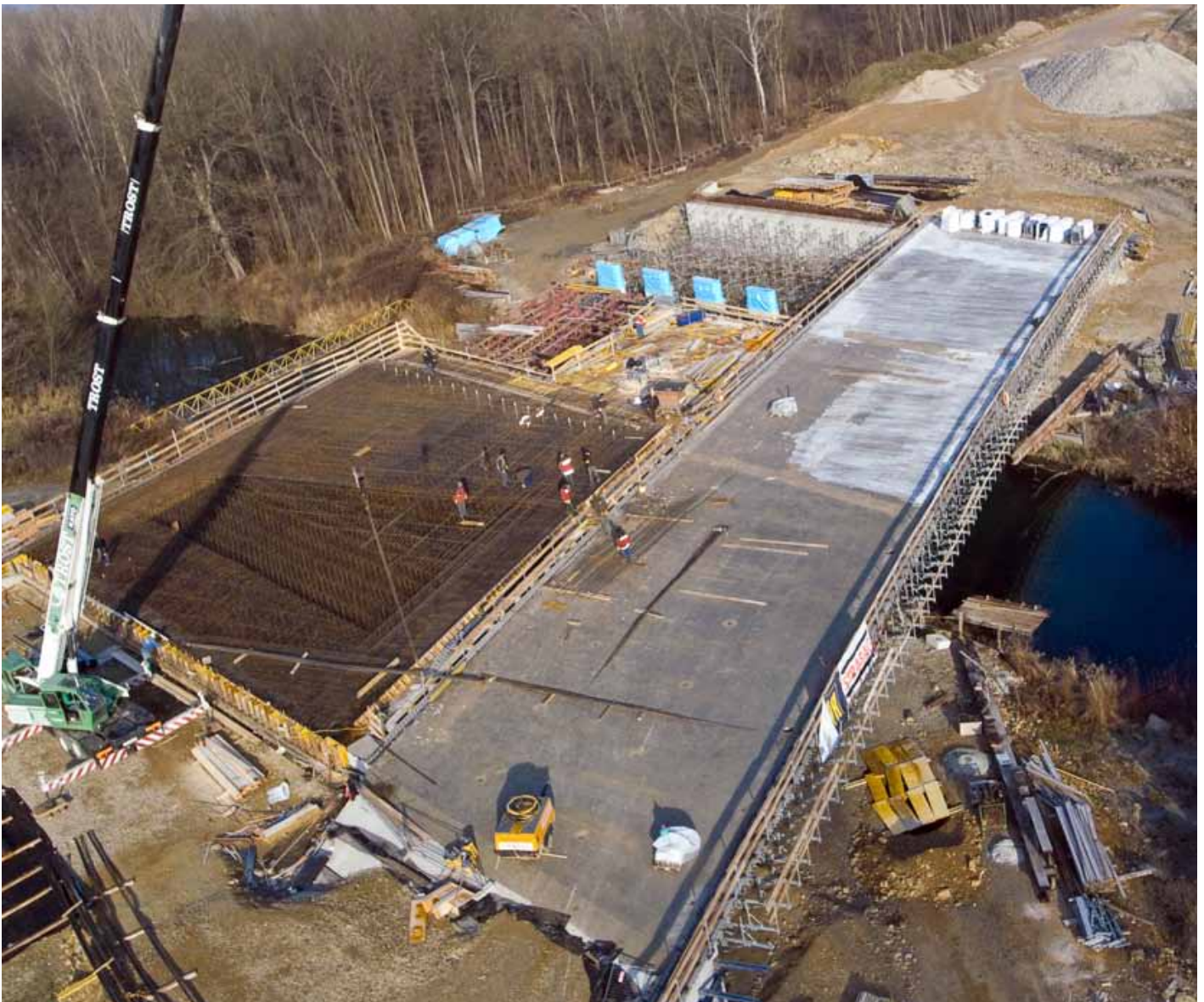
Tragwerksherstellung S33 - Marktwasserbrücke (integrale Brücke)
