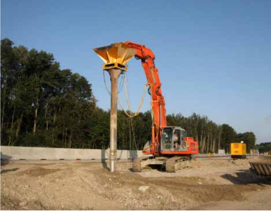
Rüttelstopfverdichtung bei Objekt LB37.Ü01
