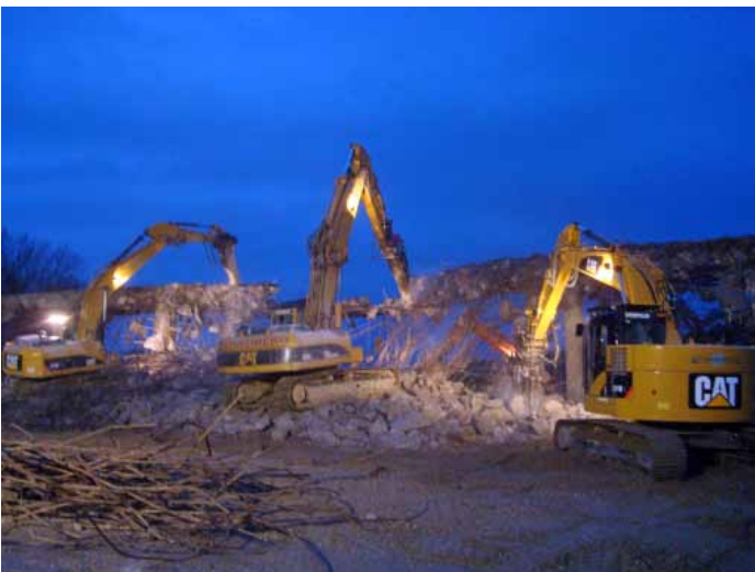
Brückenabbruch S33.Ü12 im Schichtbetrieb (hier Nacht)
