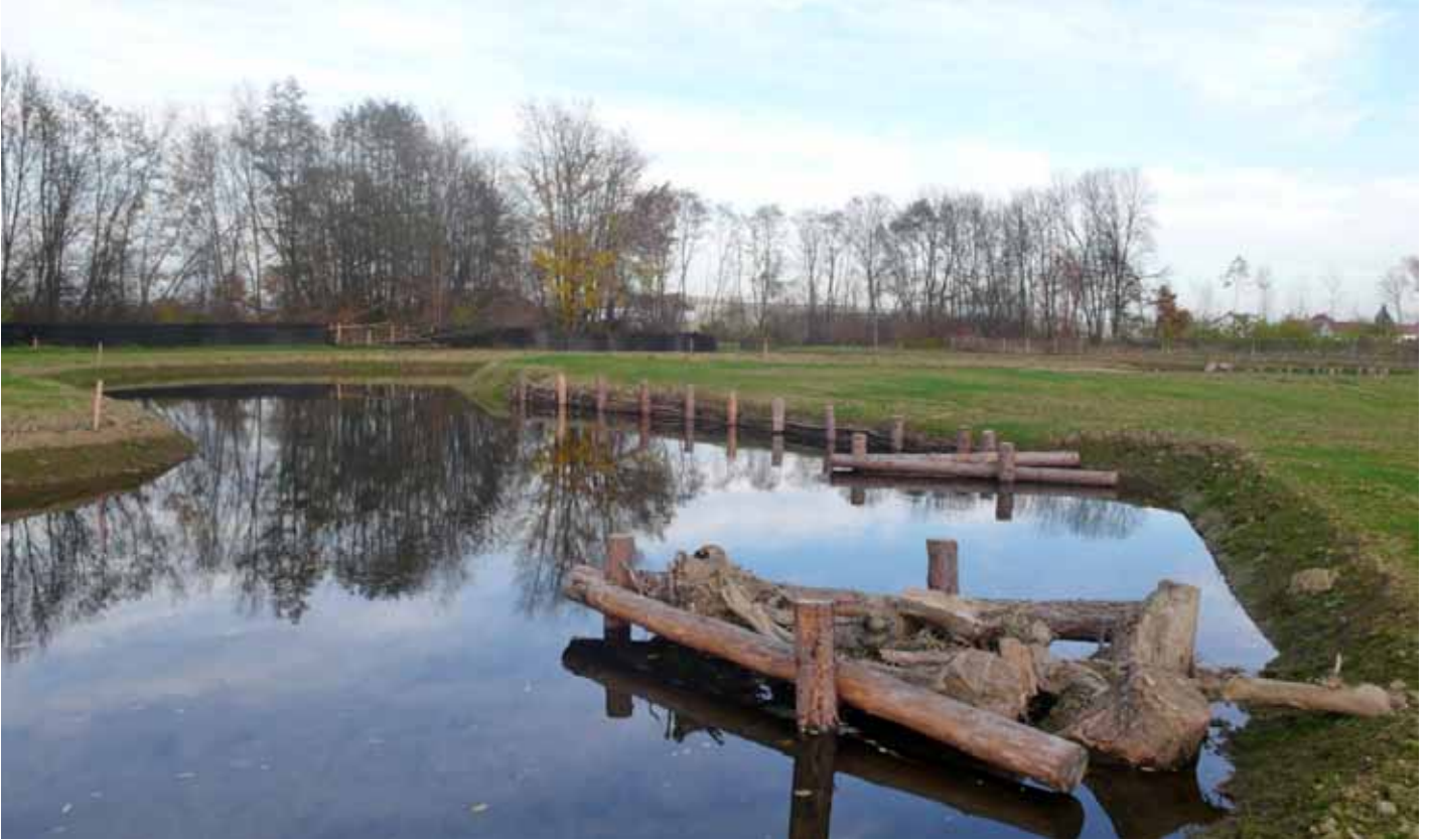
Geflutetes neues Mühlkampgerinne südlich der S5 mit Dreiecksbuhnen (Fischeinstände), Oktober 2008
