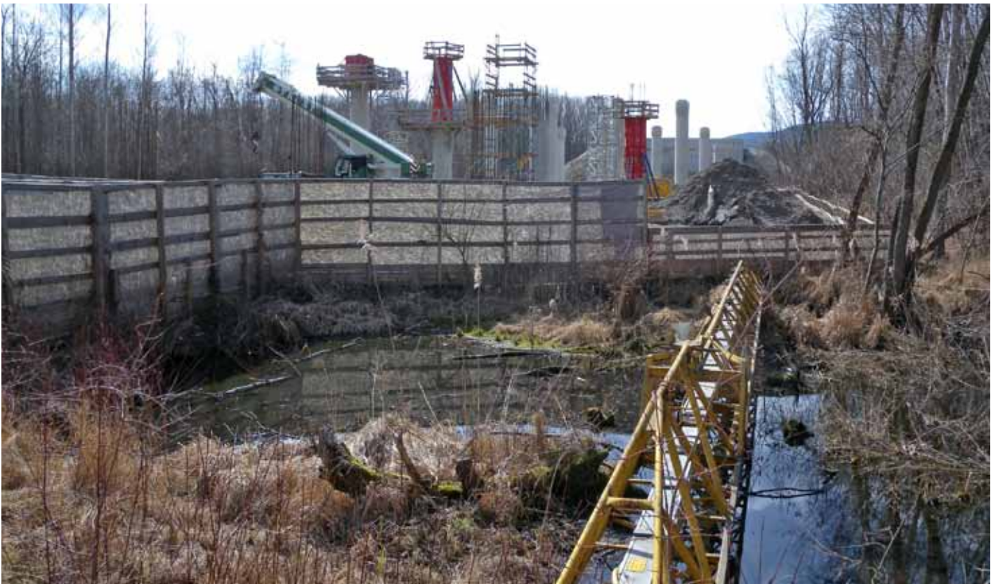
Biotopschutzmaßnahmen im Bereich der Vorlandbrücke Süd, März 2009
